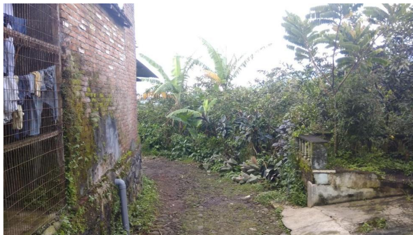
Gambar 4. Akses jalan sebelum pengembangan Infrastruktur
